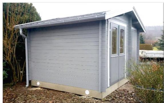
mit Sockelumkleidung und Lüftungssieben
